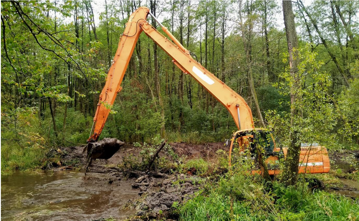
Рис. 11. Земляні роботи з використанням важкої техніки під час відновлення водосховища як місця розмноження амфібій
